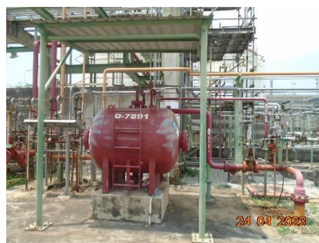
ภาพที่ 2.1-55 ระบบดับเพลิงบริเวณที่มีขนถ่ายวัตถุดิบ
