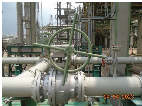
ภาพที่ 2.1-43 Black Valve บริเวณแนวท่อขนส่ง
