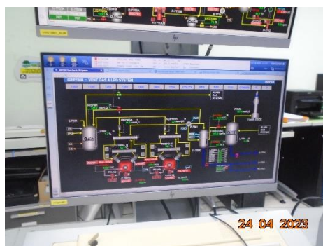
ภาพที่ 2.1-3 ระบบ DCS ที่ควบคุมการระบายก๊าซจากแหล่งกำเนิดเข้าสู่หอเผา
