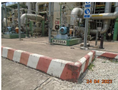
ภาพที่ 2.1-35 คันกั้นล้อมรอบบริเวณเครื่องสูบล้าง
