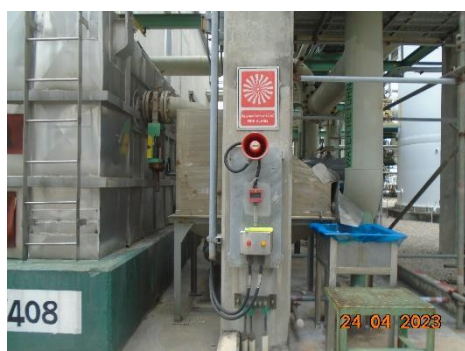
ภาพที่ 2.1-41 ระบบ Fire Alarm System ภายในลานถัง
