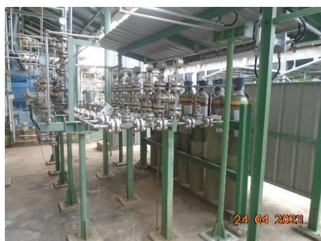
ภาพที่ 2.1-2 ถังก๊าซ CO ในระบบตรวจสอบ CO Injection และ CO Detector
