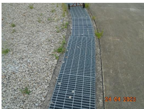
รางระบายน้ำฝน โรงงาน HDPE4
