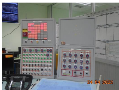
ภาพที่ 2.1-40 ระบบ Interlocks เพื่อป้องกัน Upset Condition
