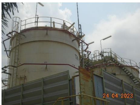
ภาพที่ 2.1-37 ตำแหน่งความสูงของ Relief Header
