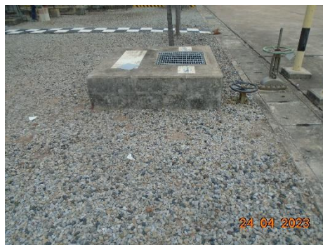
รางระบายน้ำรวบรวมน้ำเสียในกระบวนการผลิต โรงงาน PP3
