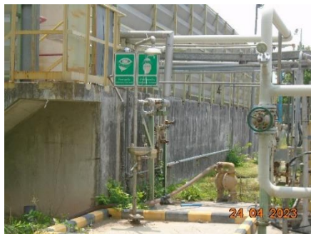
ภาพที่ 2.1-48 ระบบ Safety Showers ภายในลานถัง
