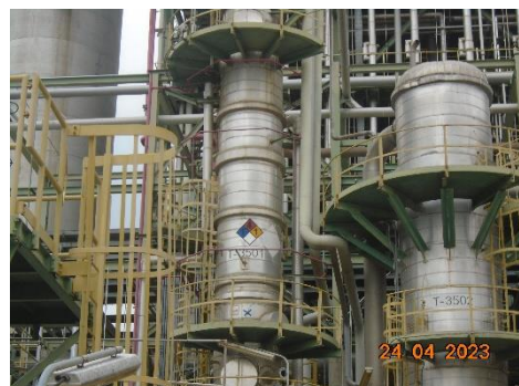
ภาพที่ 2.1-38 ระบบการพ่นน้ำลงบน Reactor บริเวณ Polymerization
