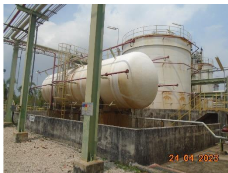
ภาพที่ 2.1-44 ถังเก็บวัตถุดิบใน Dike Area
