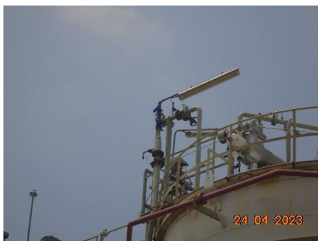
ภาพที่ 2.1-47 ระบบ Safety Relief Valve ภายในลานถัง
