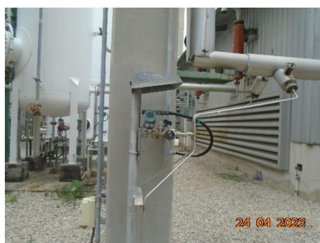
ภาพที่ 2.1-42 Pressure Indicator บริเวณท่อขนส่ง ภายในโรงงาน
